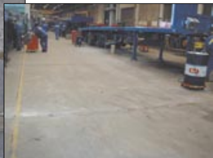
Fahrzeugwerke Faymonville AG, Billingen/Belgium: Repairing expansion joints
