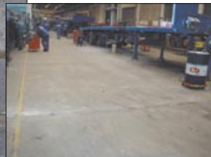
Fahrzeugwerke Faymonville AG, Billingen/Belgium: Repairing expansion joints
